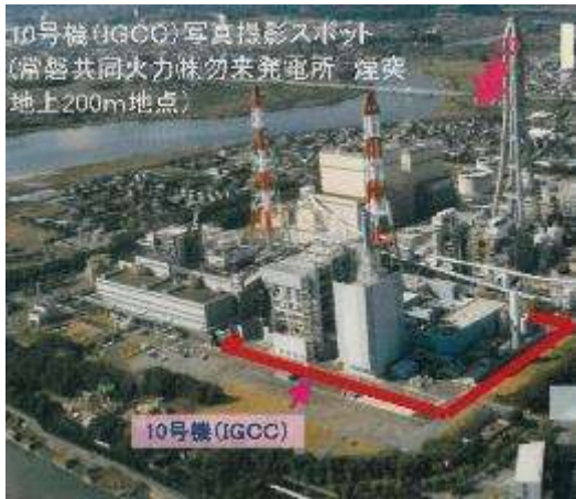
IGCC 石炭ガス化複合発電
