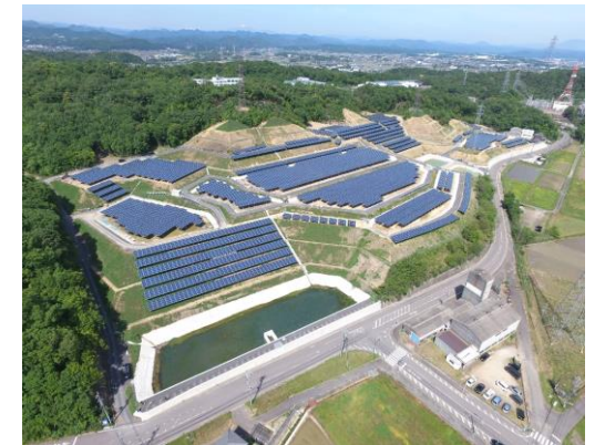
関ソーラーパーク 建設場所: 岐阜県関市
