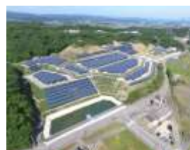
関ソーラーパーク 建設場所：岐阜県関市
