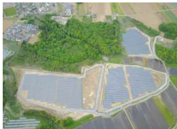
つくばみらいソーラーパーク 建設場所：茨城県つくばみらい市
