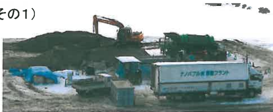
施工現場全景
