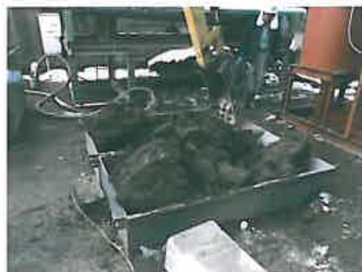
①側溝汚泥(元土) 重量測定及びサンプル採取
