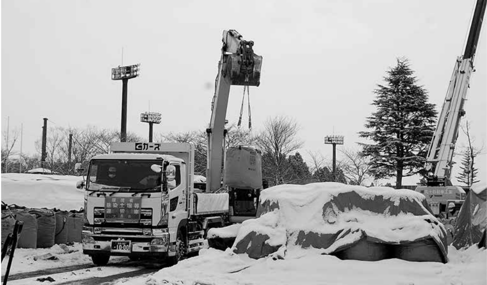
仮置場でダンプトラックへと積み込まれる除染廃棄物
