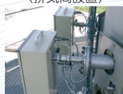
SEC box (排気筒設置)
