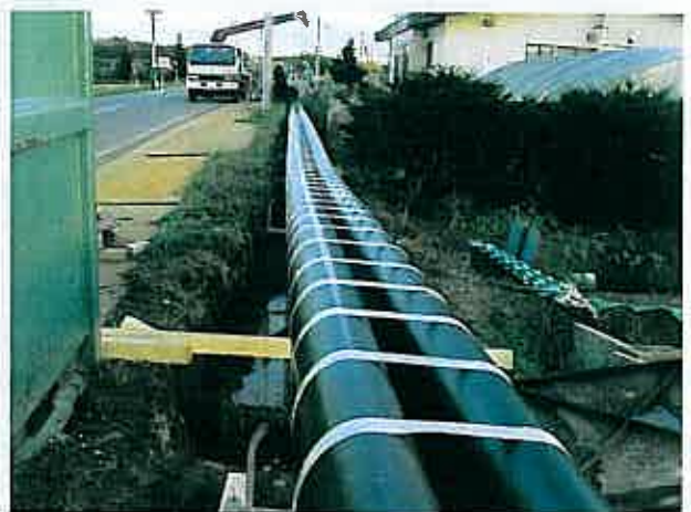
1スパン60mのバンディング完了し既設管引込み
