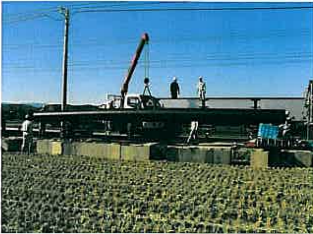
φ600ポリエチレン管現場搬入(12m直管)
