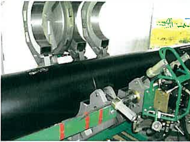
ポリエチレン管のバット融着
