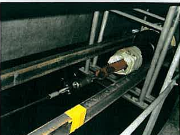
ワイヤーによるポリエチレン管の引込み状況
