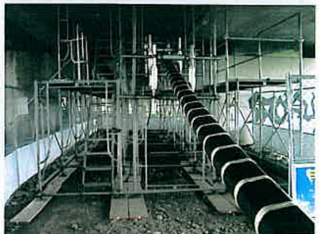
1スパン330mポリエチレン管の既設管引込み
