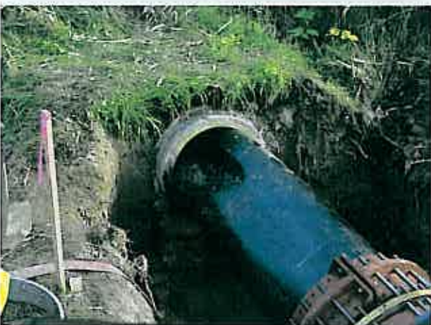
復元中のポリエチレン管の状況 (段々と膨らんでいきます)
